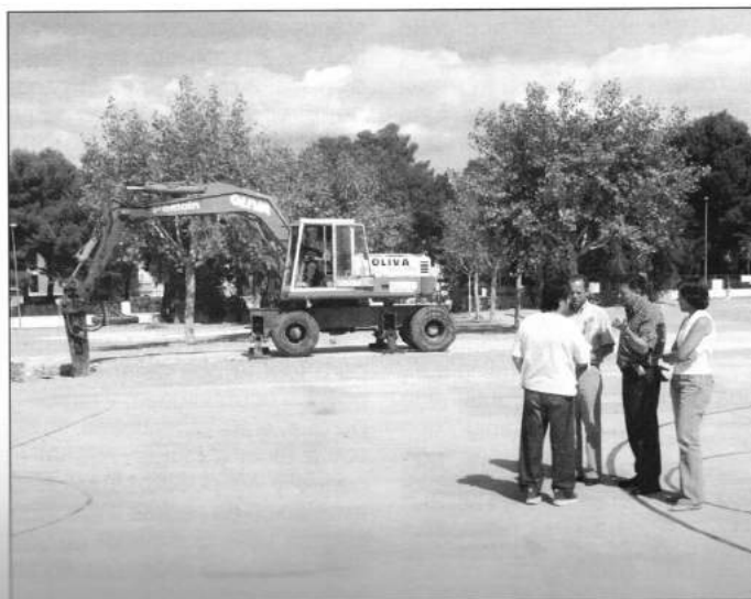
Visita a las obras del nuevo C.P. San Antón
